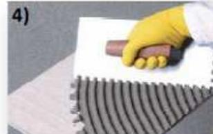
Aplicar a argamassa na parte de trás da placa cerâmica com o lado liso da desempenadeira, depois forme os cordões paralelos com a parte dentada da desempenadeira.
