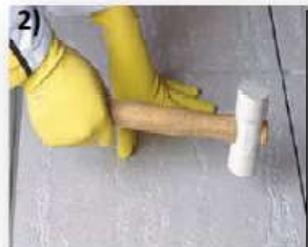
Aplicar a peça ligeiramente fora de posição, cruzando os cordões do tardo e do contrapiso. Arrastar a placa até a posição final, pressionando com os dedos e batendo com martelo de borracha para Amassar os cordões de argamassa.
