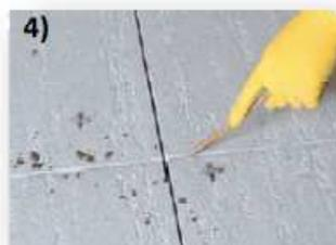
Remover os excessos de argamassa existentes nas juntas em no máximo até 1 hora após o assentamento
